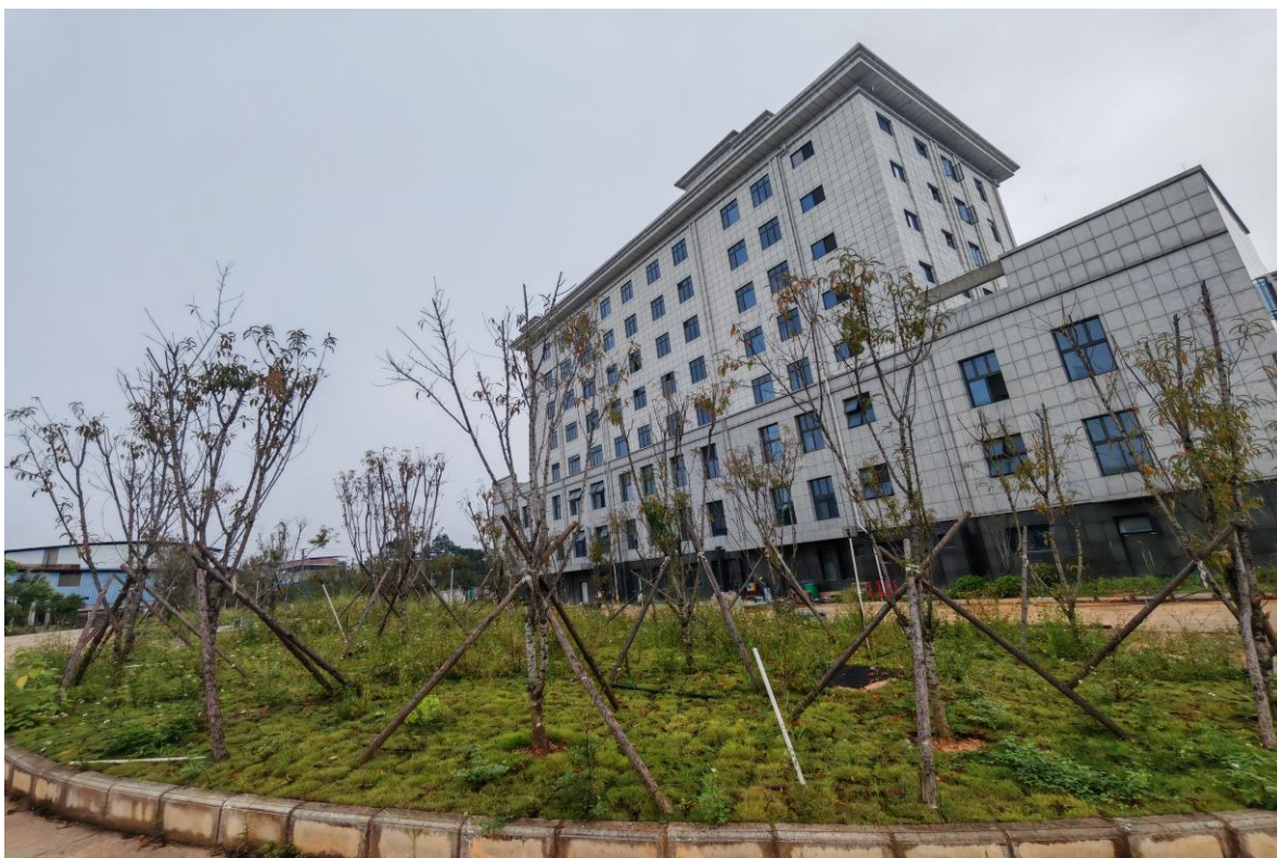
项目完工后现状 2（2025.8）
