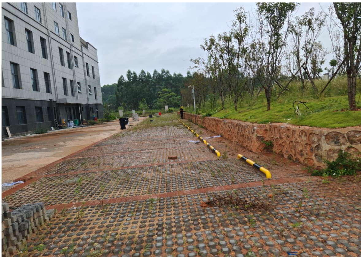
项目完工后现状 3 (2025.8)
