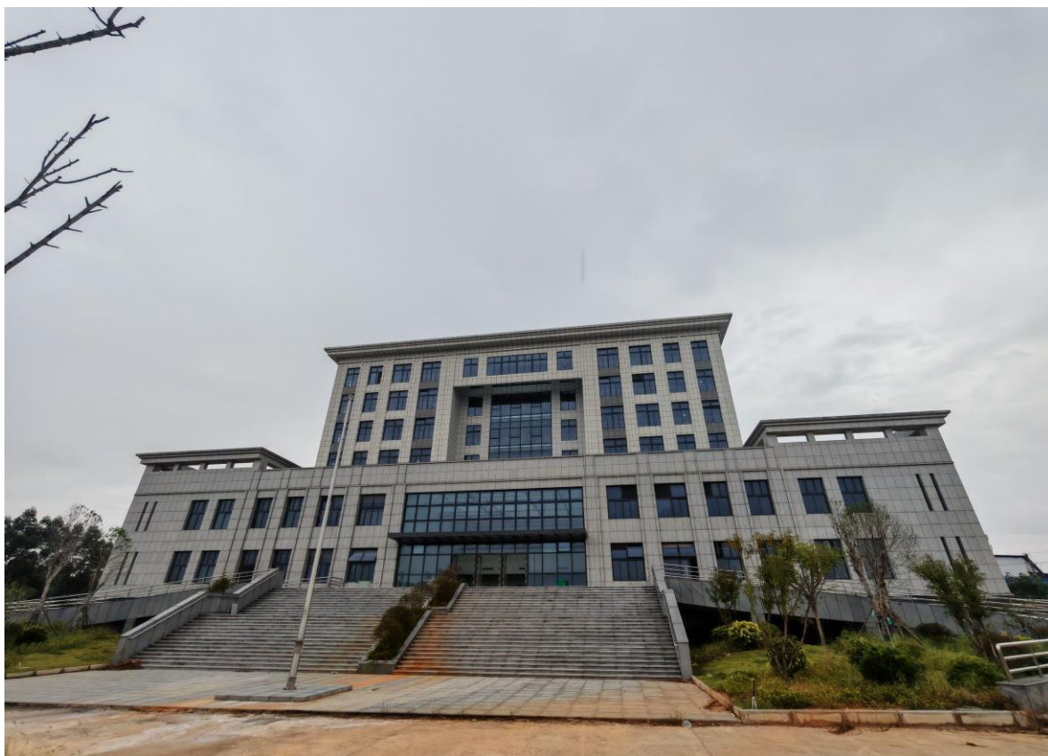
项目完工后现状 1（2025.8）
