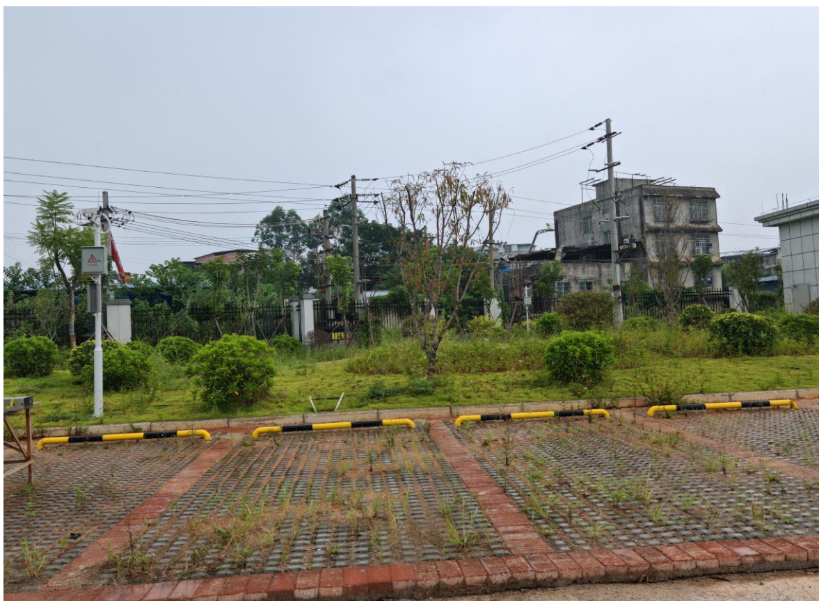
项目完工后现状 6 (2025.8)
