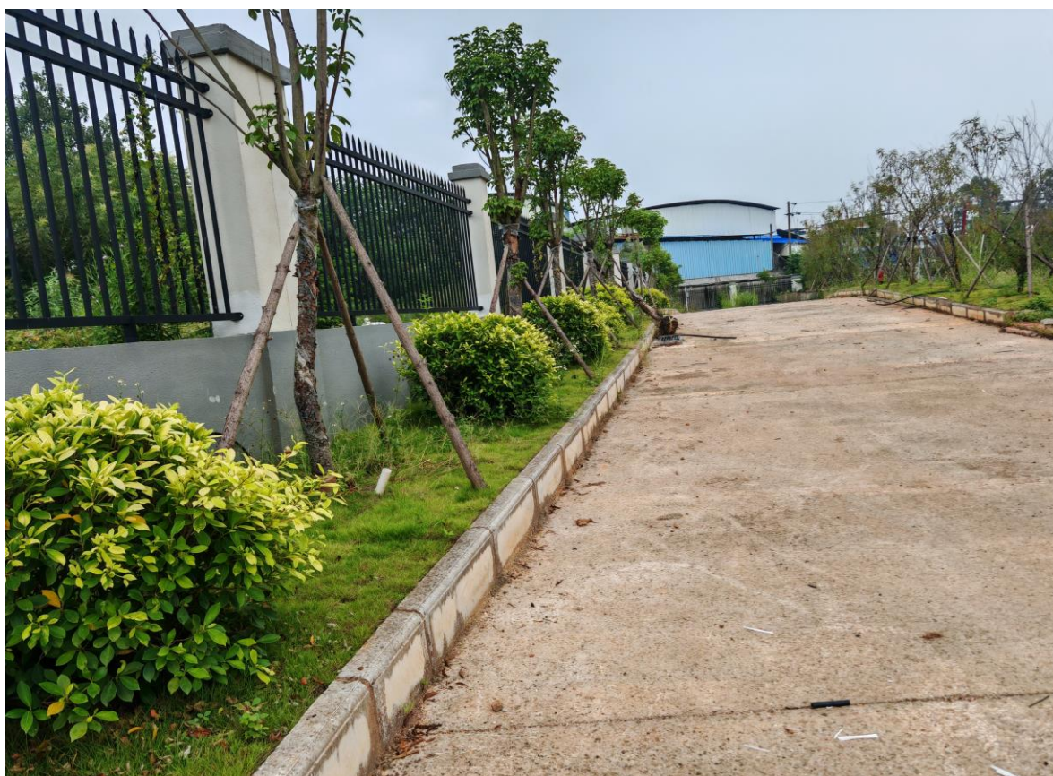
项目完工后现状 4 (2025.8)
