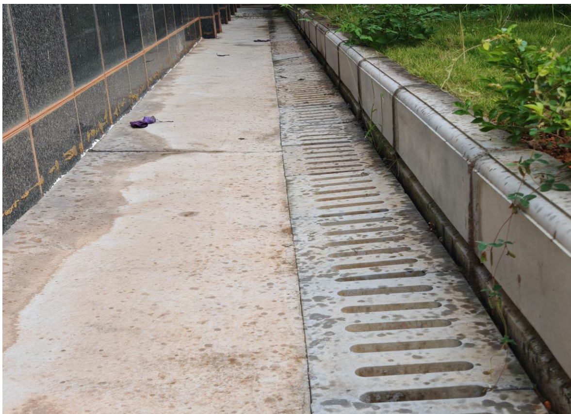
项目完工后现状 5 (2025.8)
