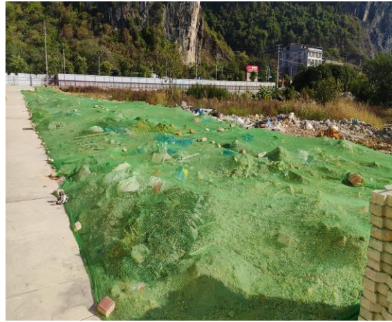
密目网临时覆盖
