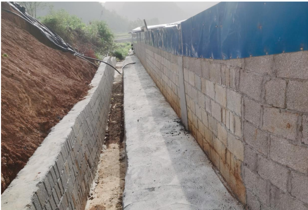
砖砌排水沟现状
