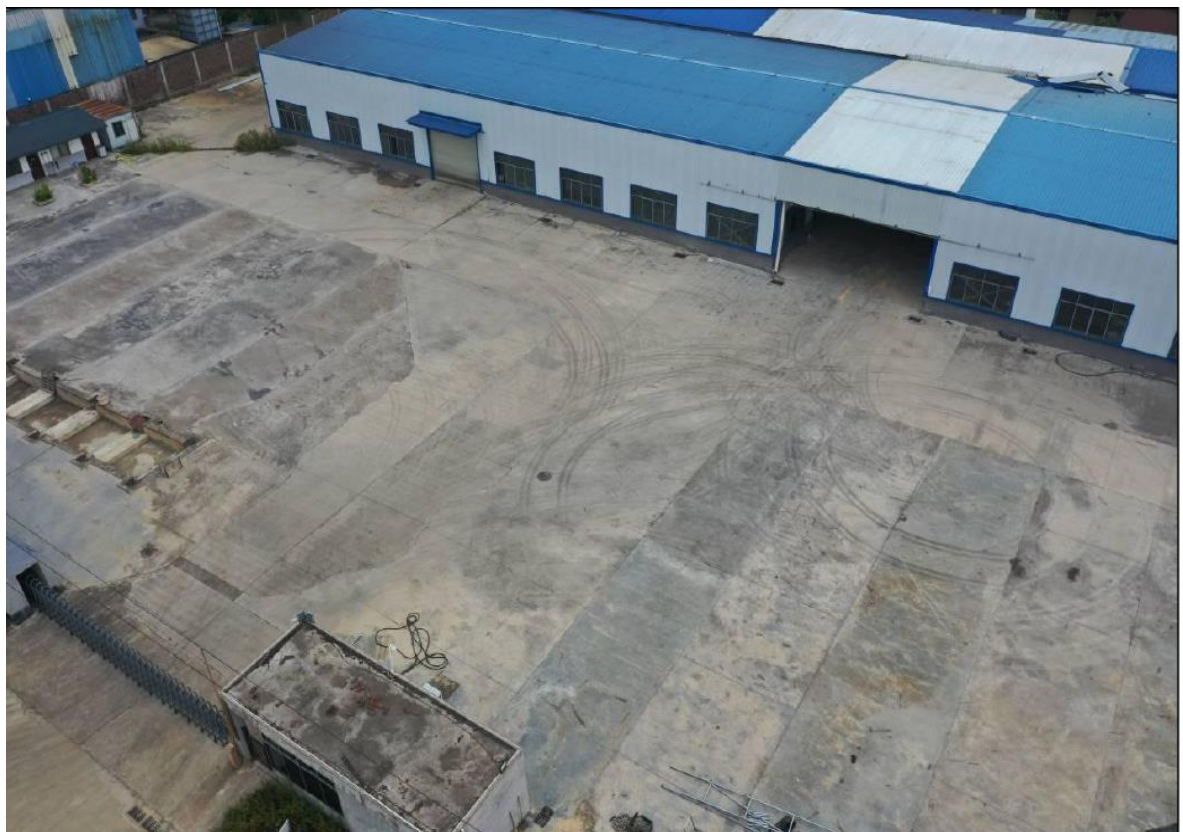
项目完工后现状
