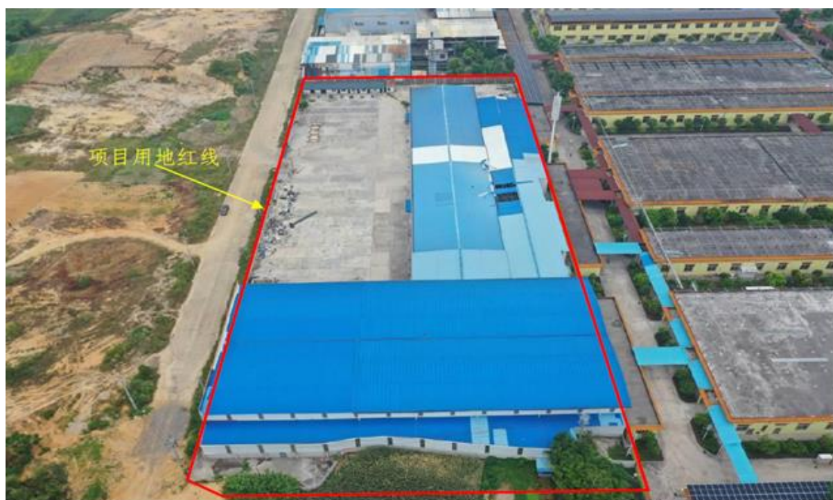
项目完工后现状
