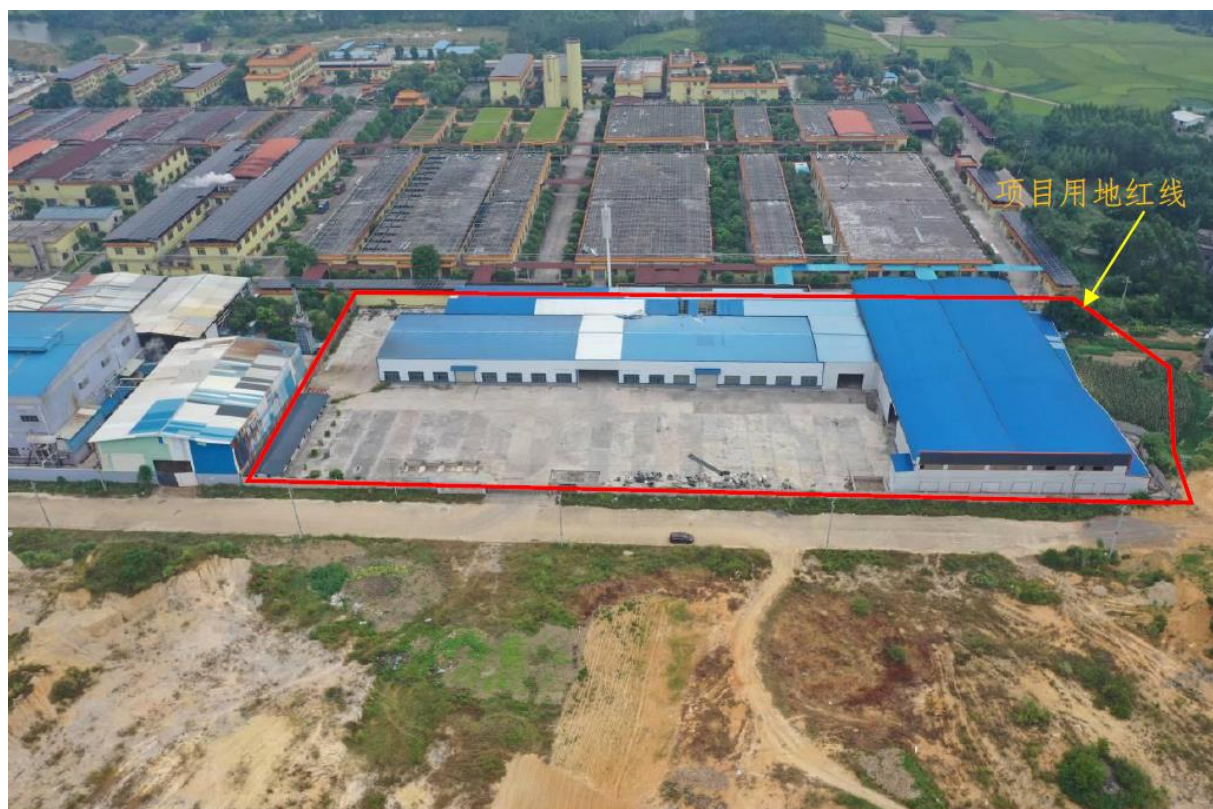
项目完工后现状
