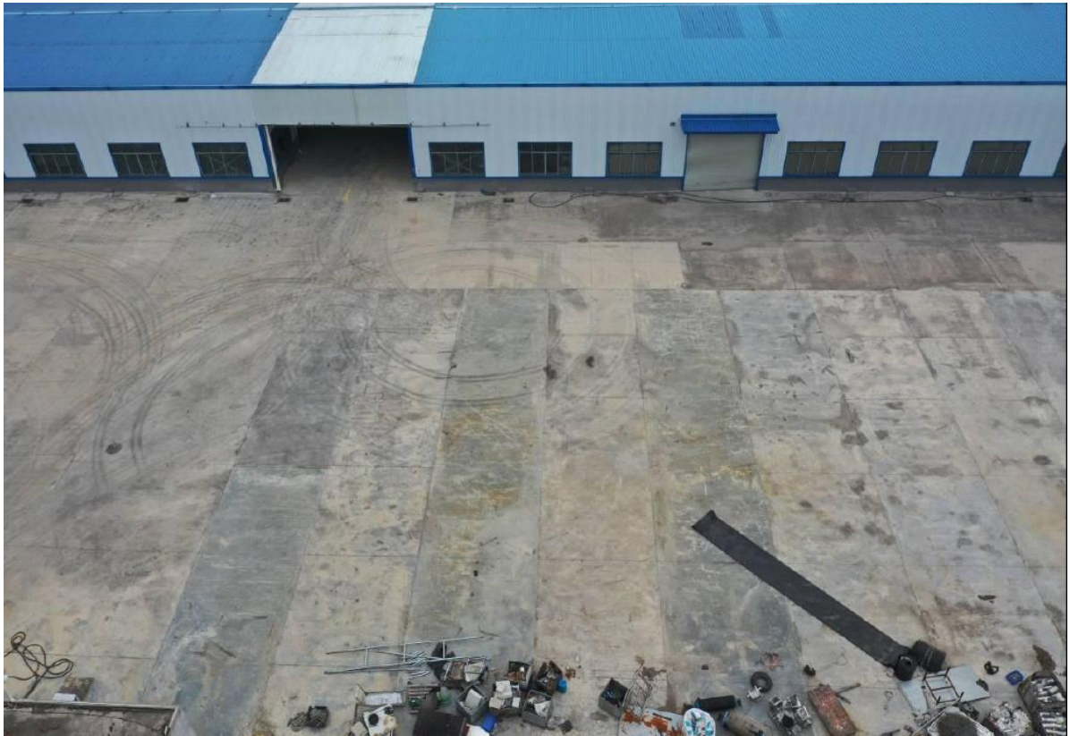
项目完工后现状
