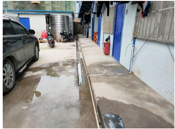
施工生活区临时排水沟
