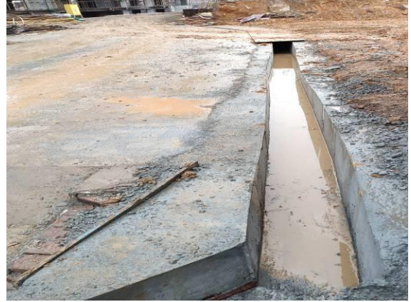
砌砖临时排水沟
