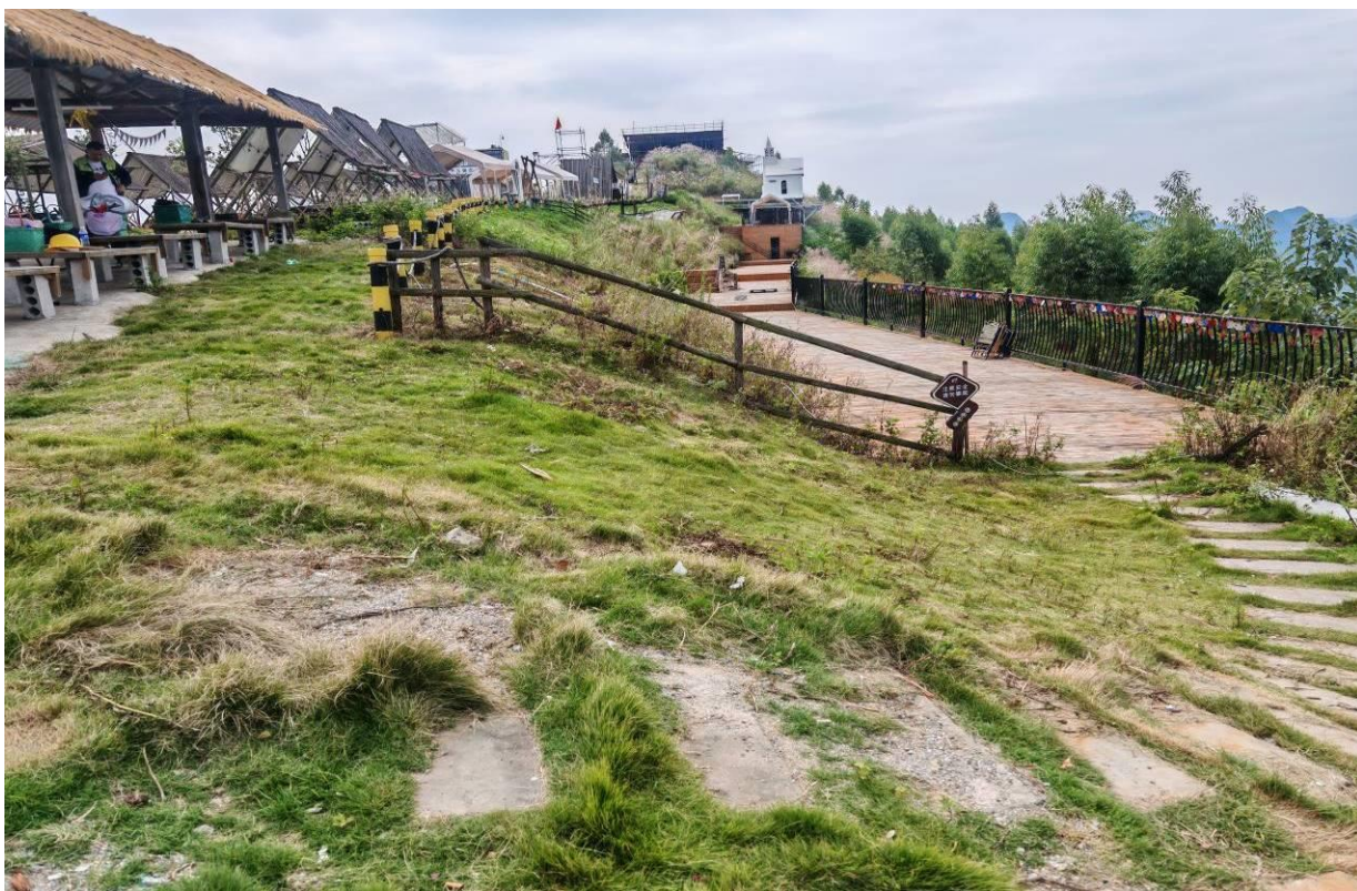
项目完工后现状 4 (2026.7)
