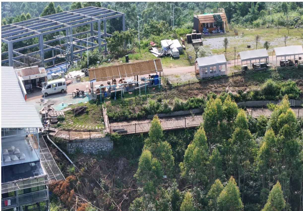
项目完工后现状 3 (2026.7)
