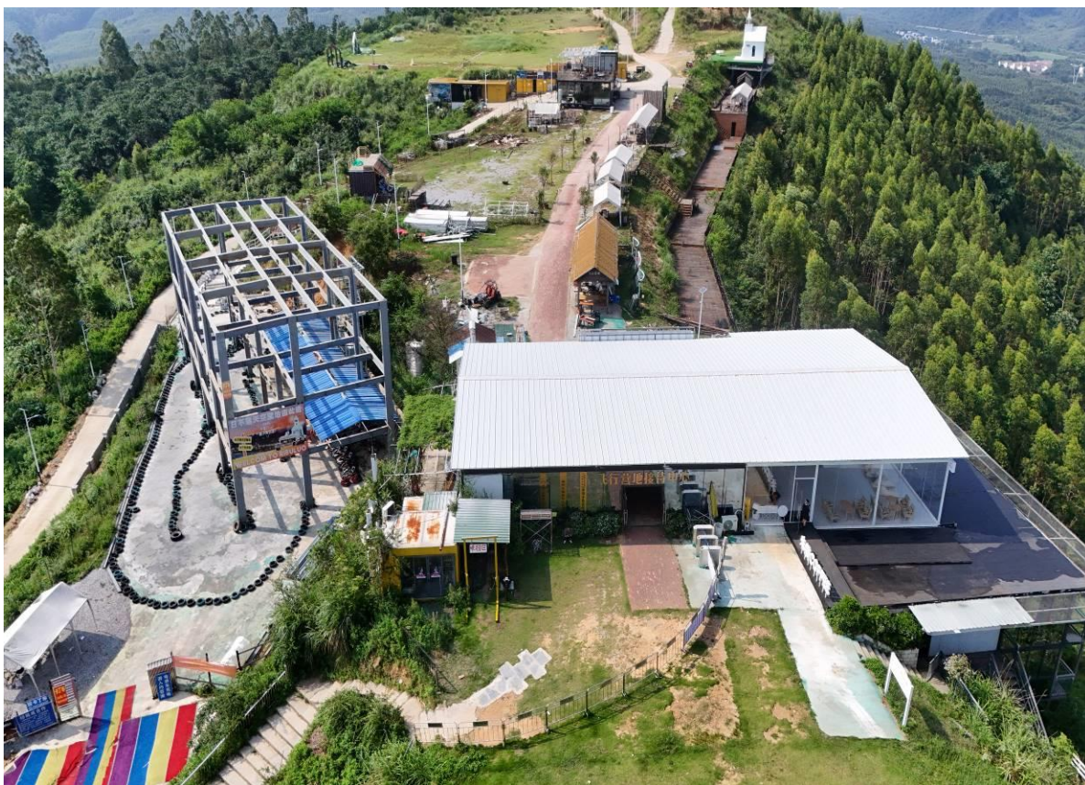
项目完工后现状 2 (2026.7)
