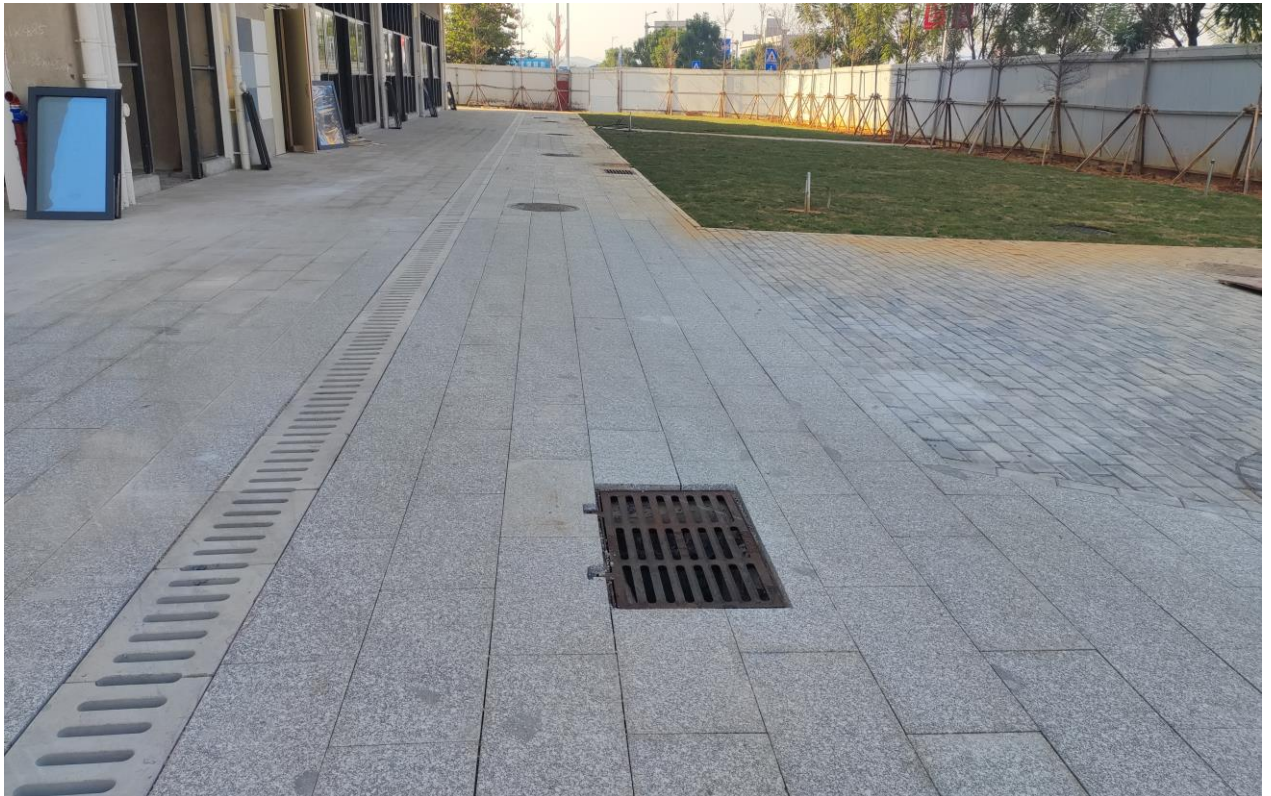
盖板水沟及雨水井现状（2024 年 10 月）
