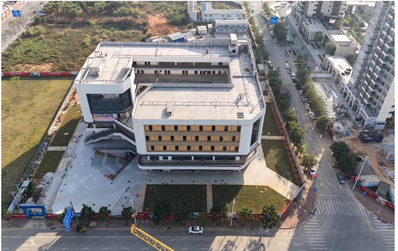
项目完工后现状（2024 年 10 月）
