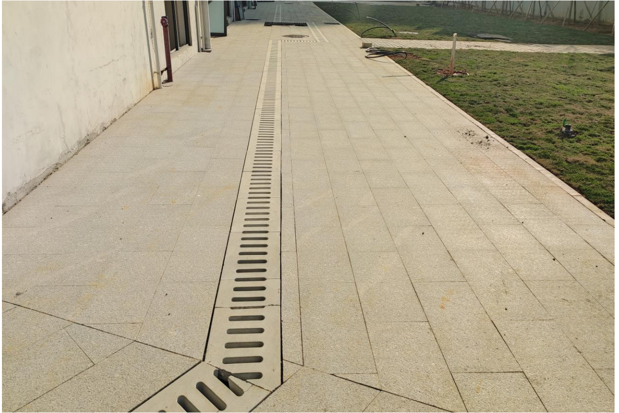
盖板排水沟现状（2024 年 10 月）
