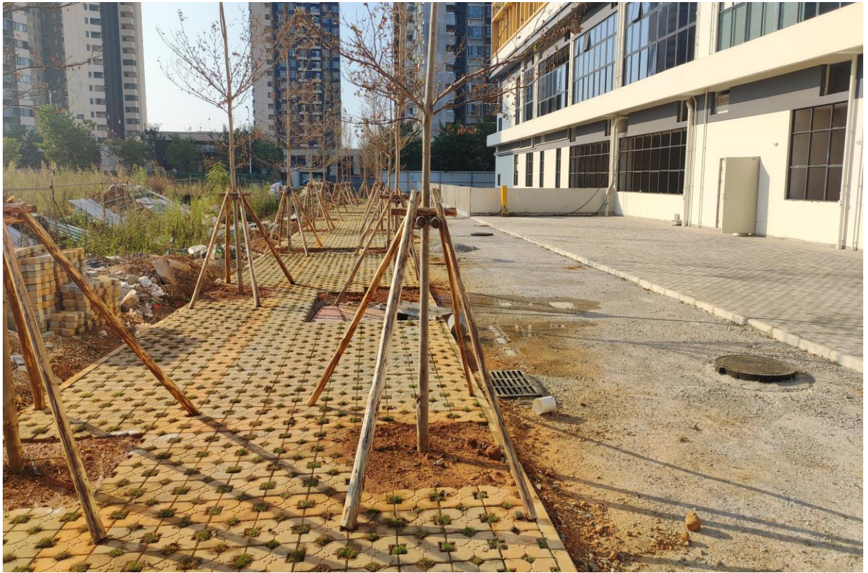
项目植树及透水砖铺设现状（2024 年 10 月）
