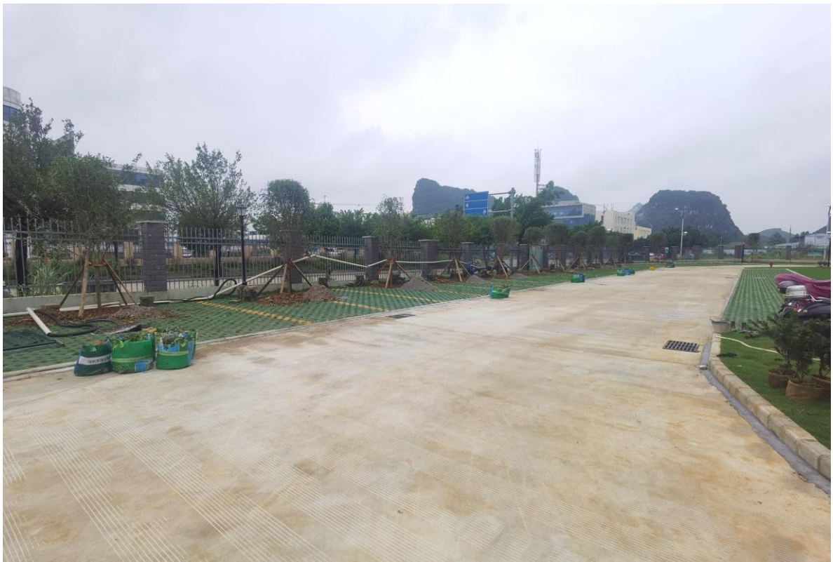
项目完工后现状 4（2024 年 8 月）
