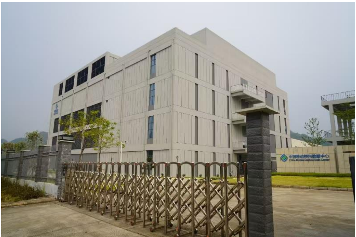
项目完工后现状 6（2024 年 8 月）
