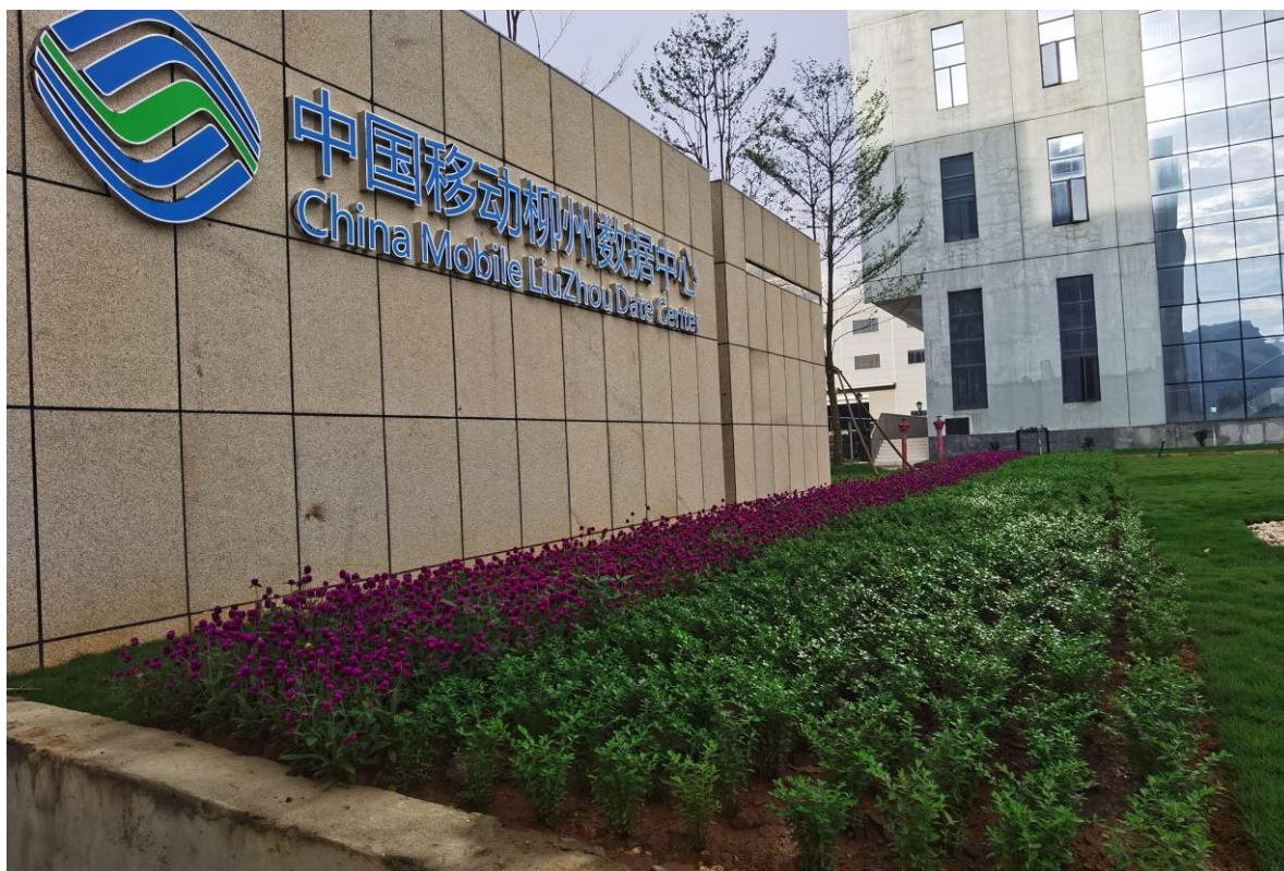
项目完工后现状 2（2024 年 8 月）
