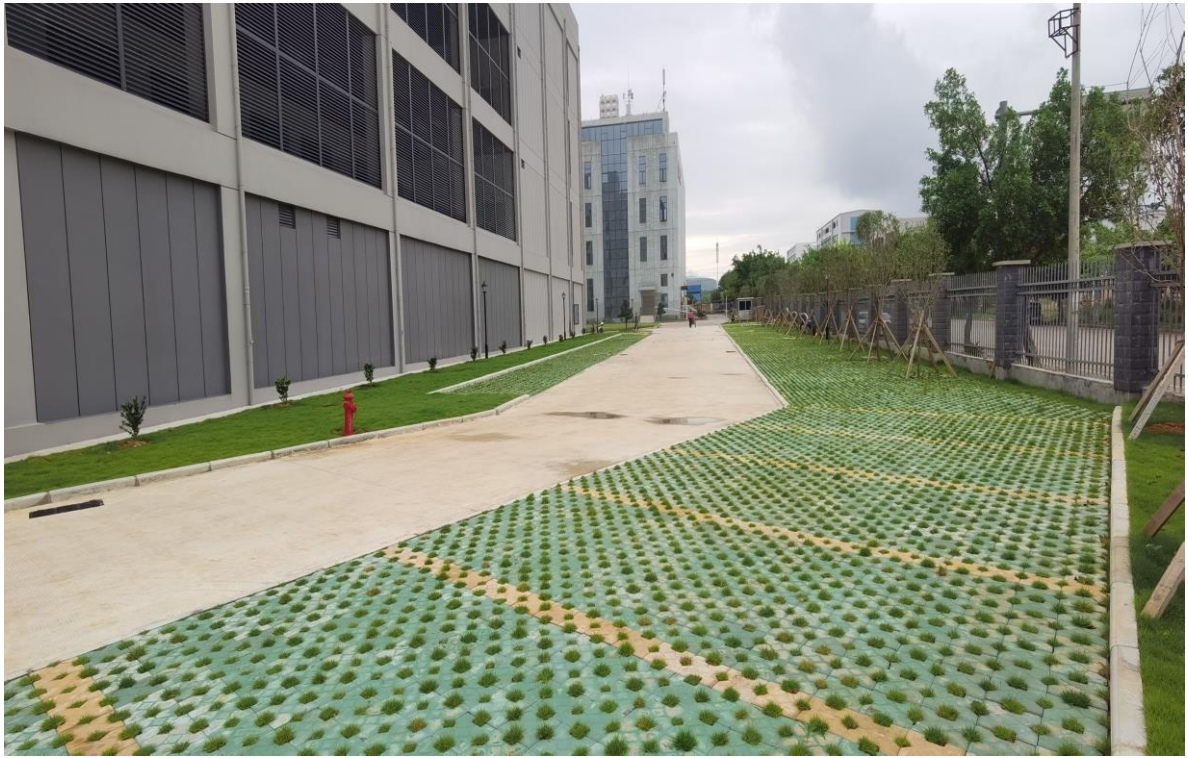
项目完工后现状 5（2024 年 8 月）
