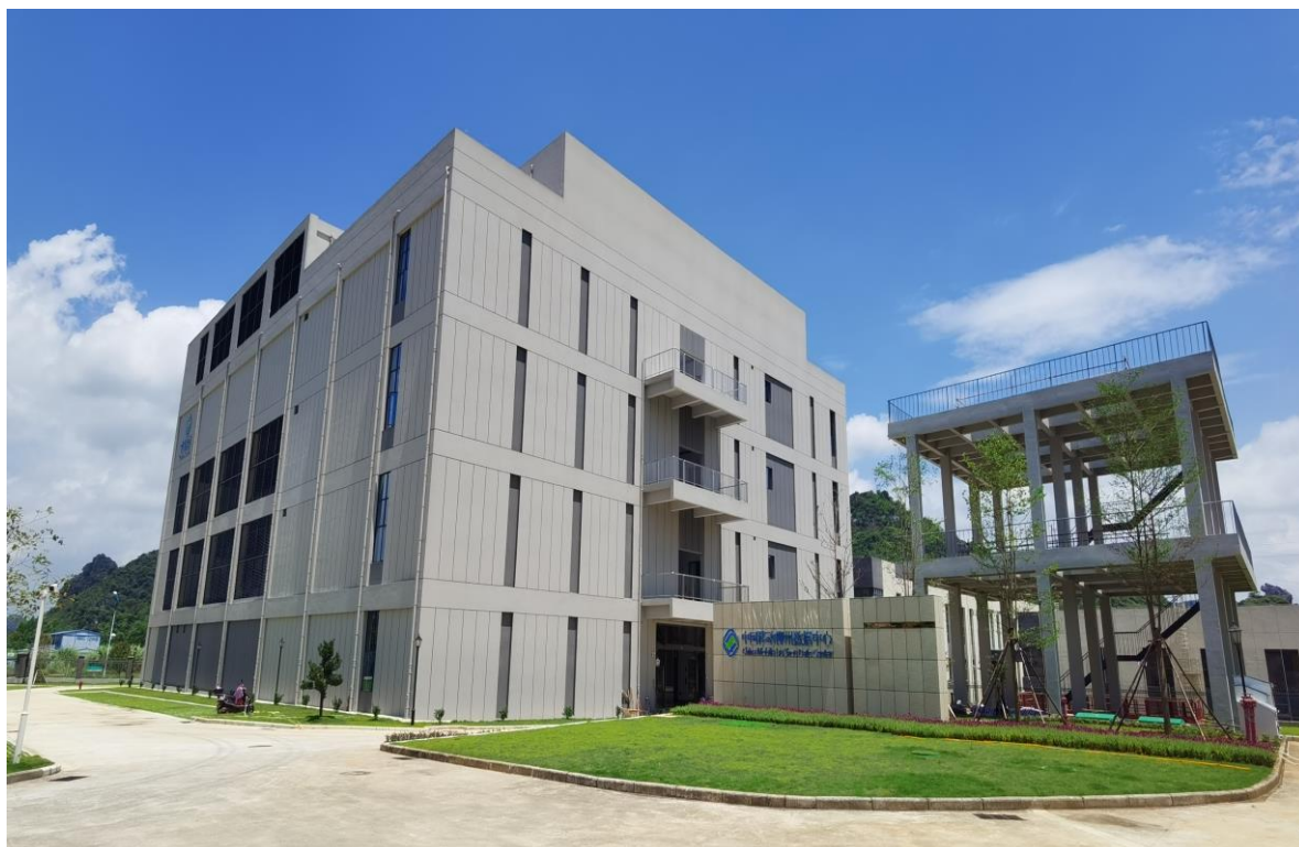
项目完工后现状 1（2024 年 8 月）
