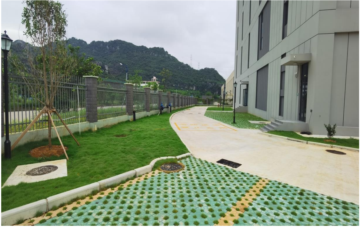
项目完工后现状 3（2024 年 7 月）
