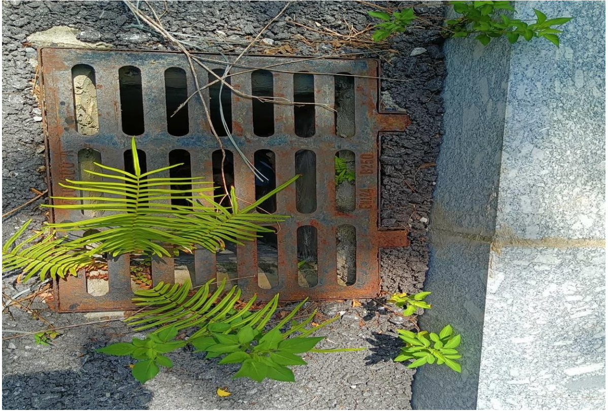
雨水井现状（2024 年 7 月）
