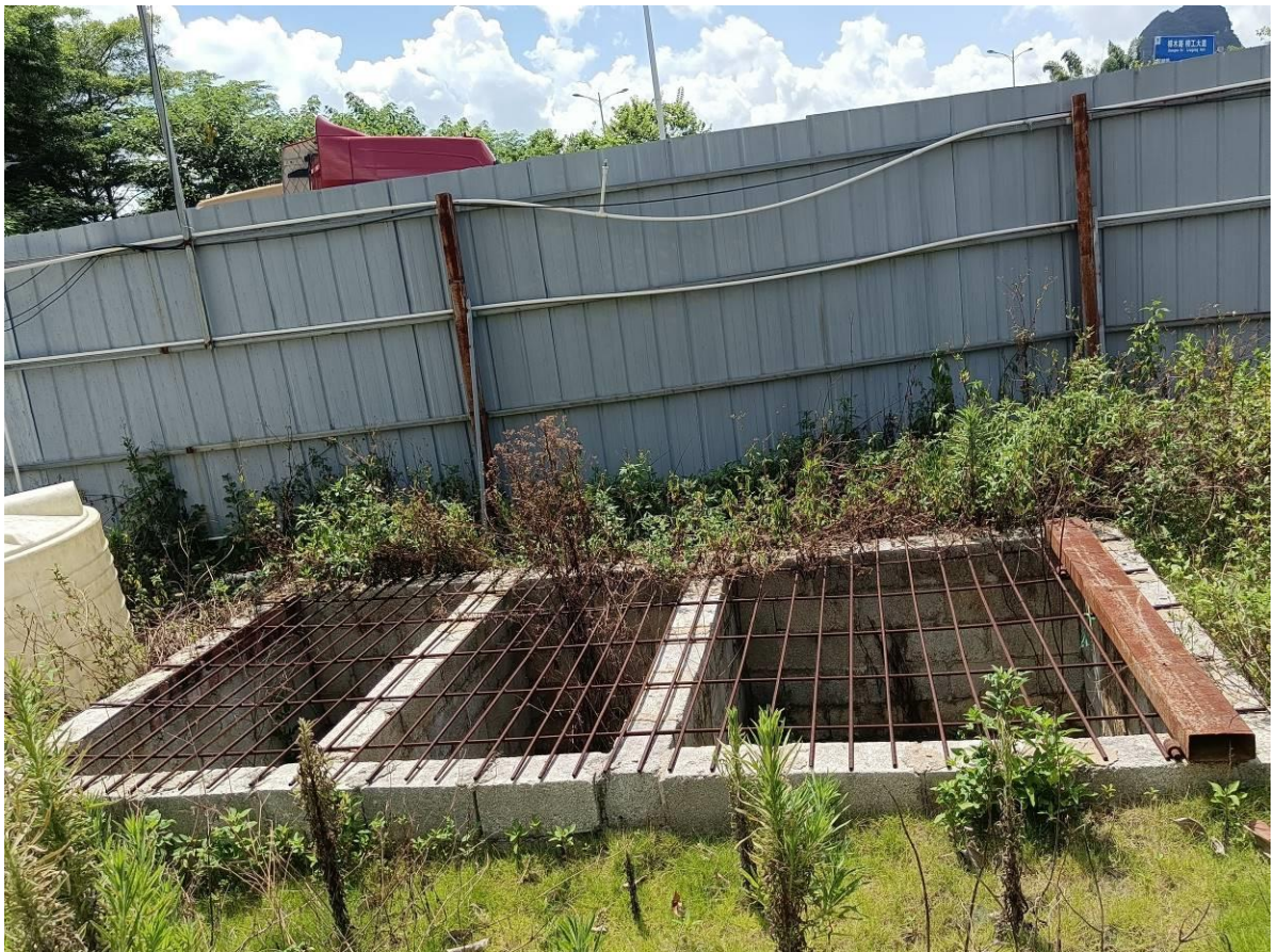
沉沙池现状（2024 年 7 月）
