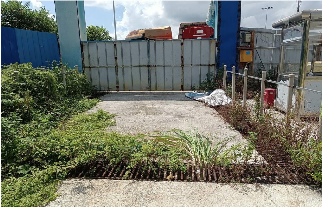
施工时的洗车池
