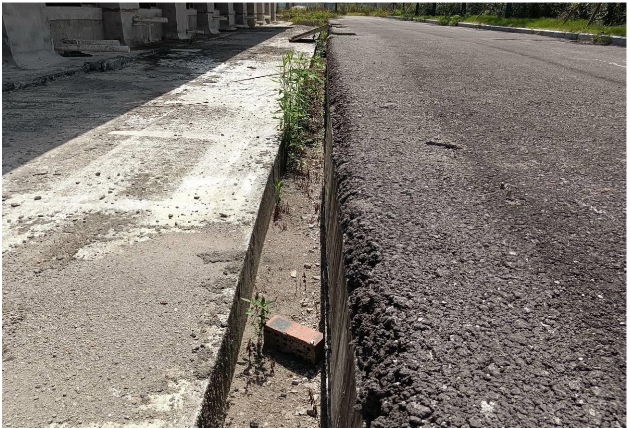
施工时的临时排水沟
