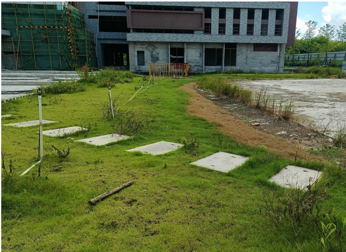
项目完工后现状 3（2024 年 7 月）
