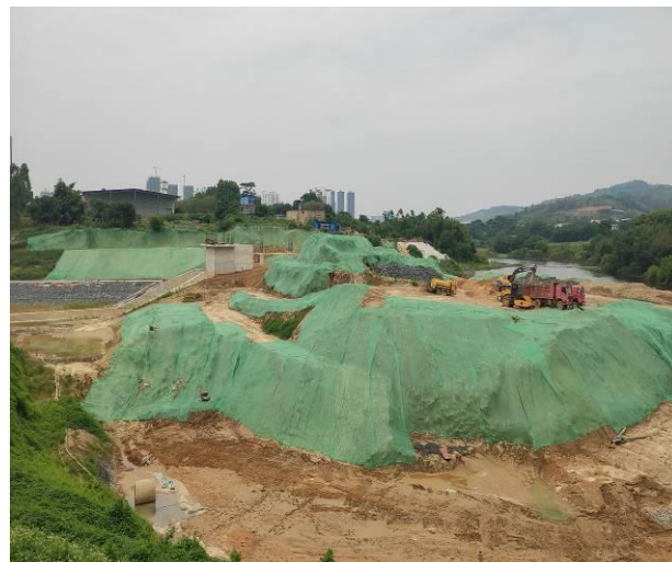
密目网临时覆盖
