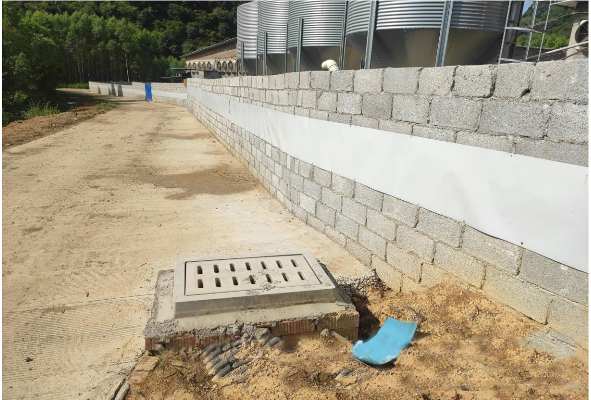
项目排水沟现状（2022.11）
