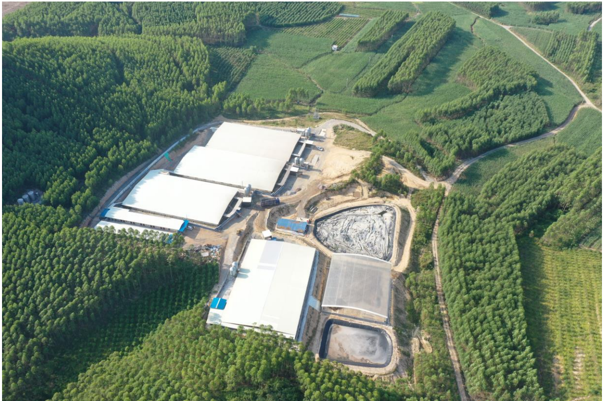
项目现状照片（2022.11）
