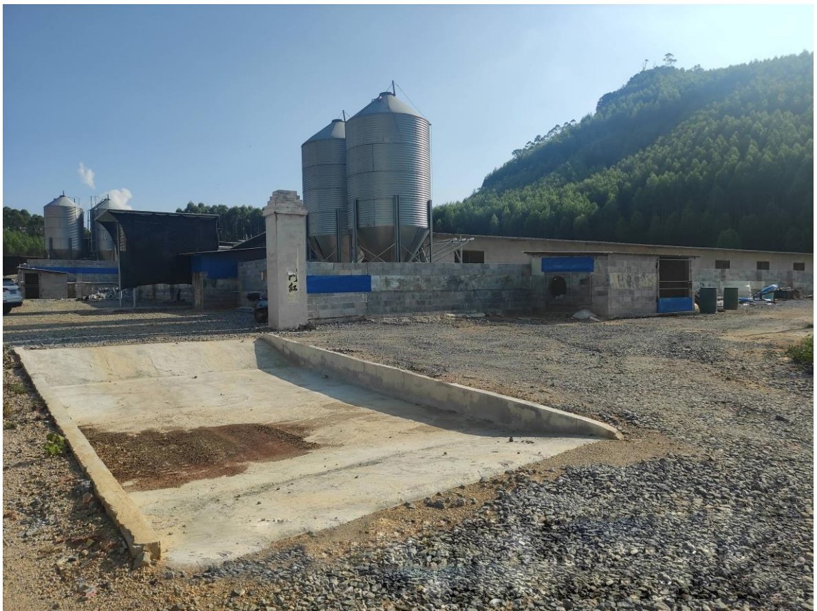
项目洗车池现状（2022.11）
