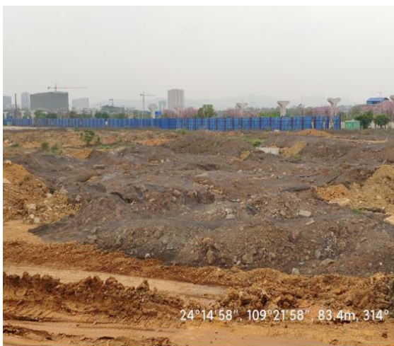
临时堆土场临时覆盖
