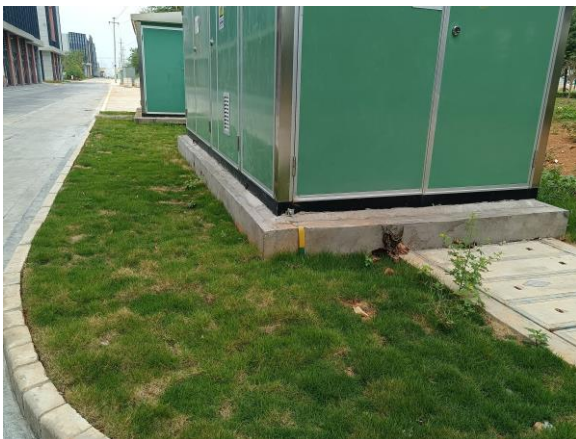
主体工程区景观绿化现状照片 3
