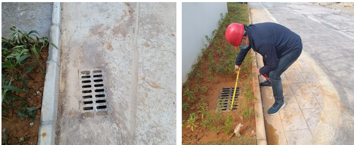
主体工程区雨水井现状照片
