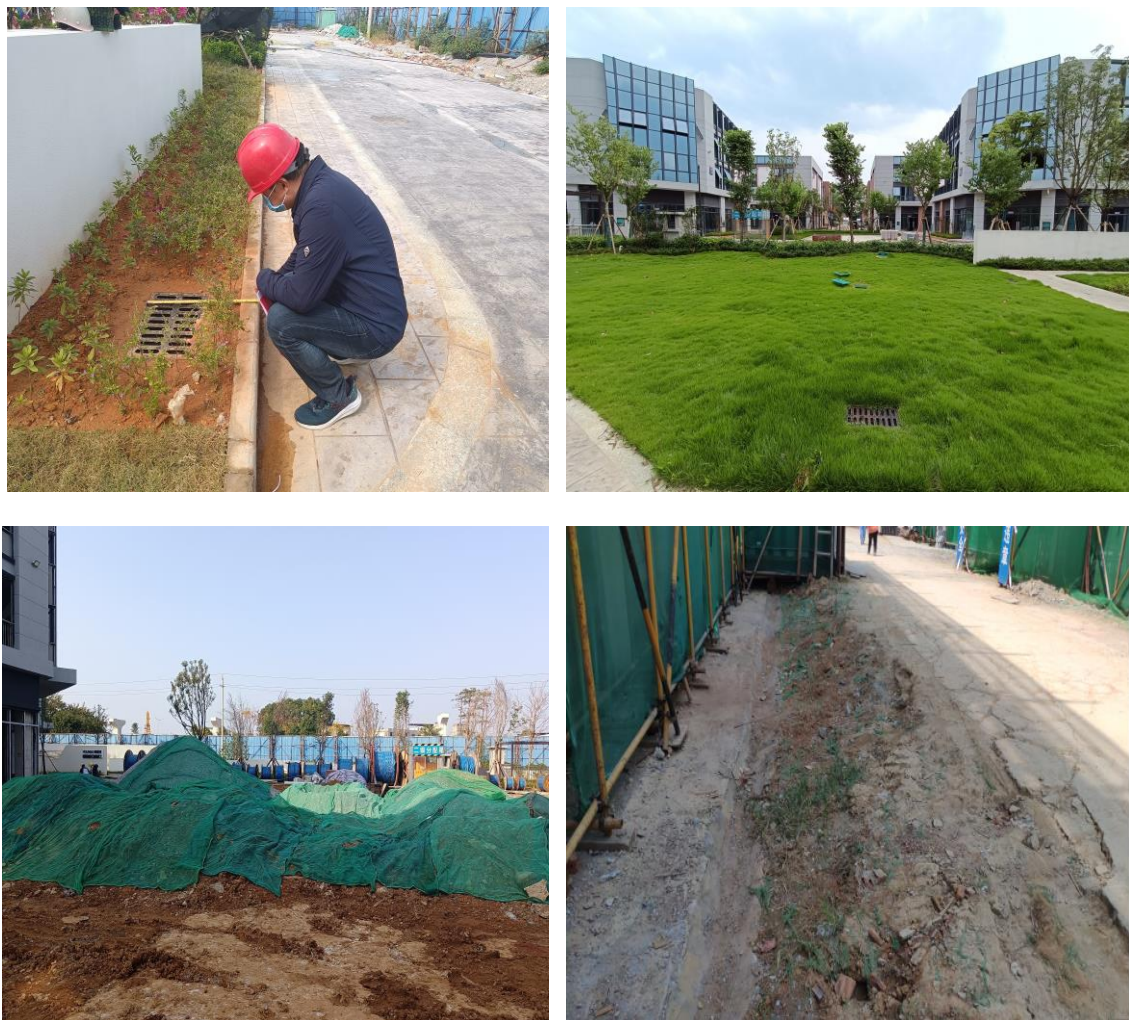
图 2.3-1 项目水土保持措施监测
