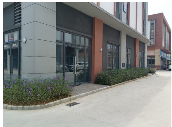
主体工程区景观绿化现状照片 2
