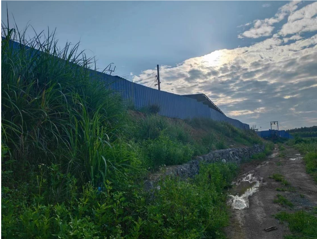
项目边坡植被现状（2023.09）
