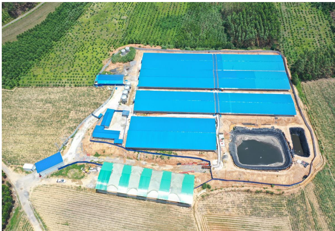
项目建成后全貌照片（2023.09）
