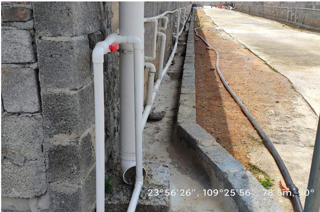
项目排水沟现状（2023.09）
