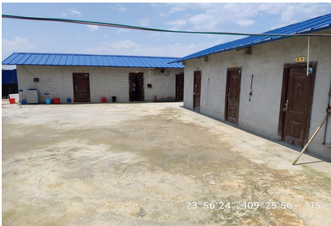
生活管理用房建成后现状（2023.09）
