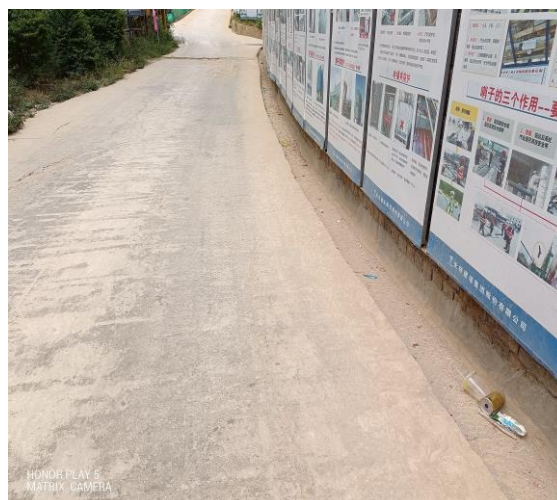
主体工程区临时排水沟
