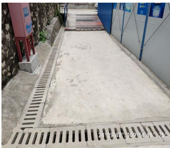
施工生产生活区排水沟
