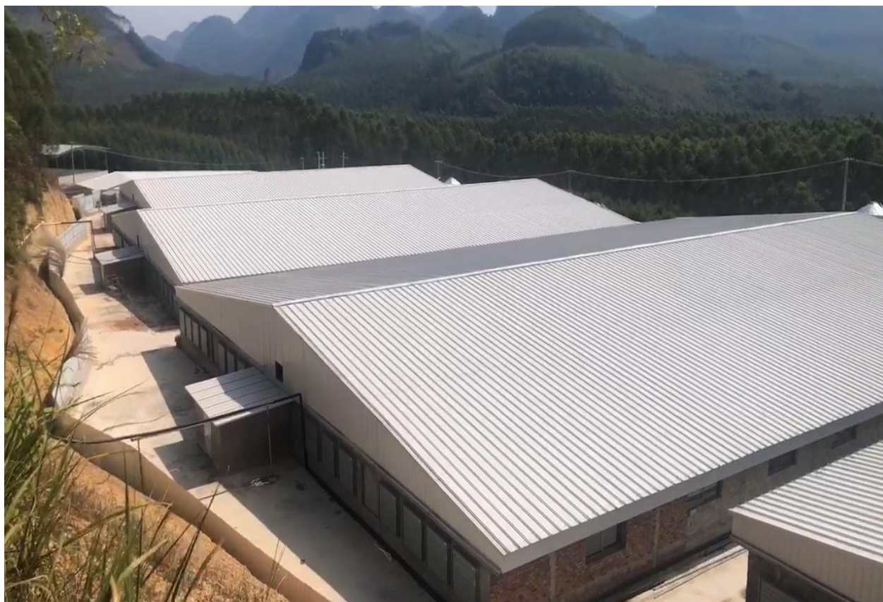
猪舍现状照片（2023. 8）
