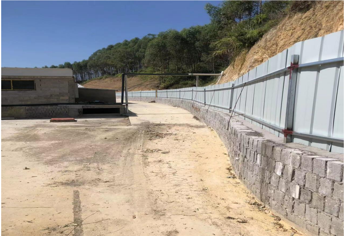
硬化道路现状（2023.8）
