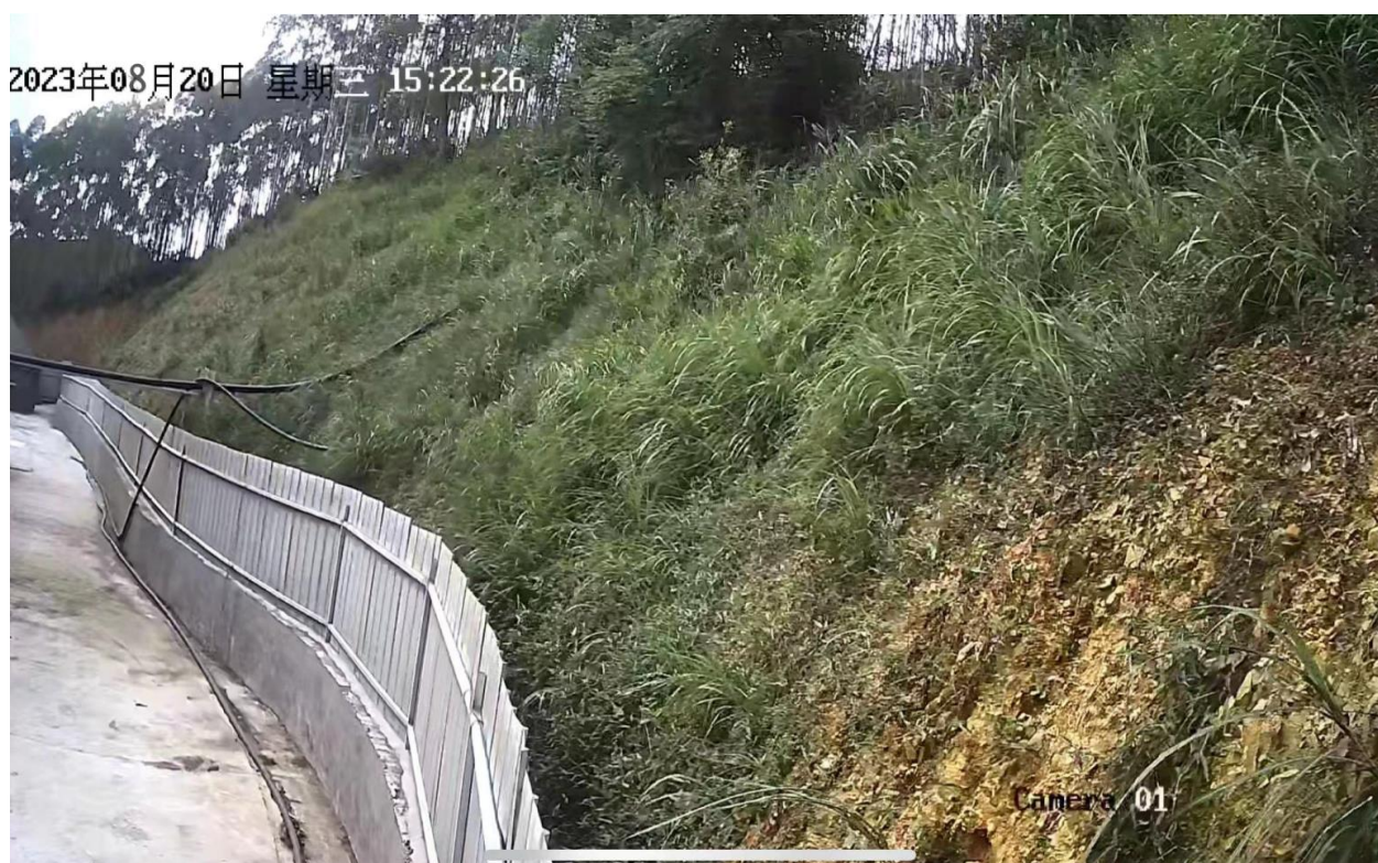
边坡植被恢复现状（2023. 8）
