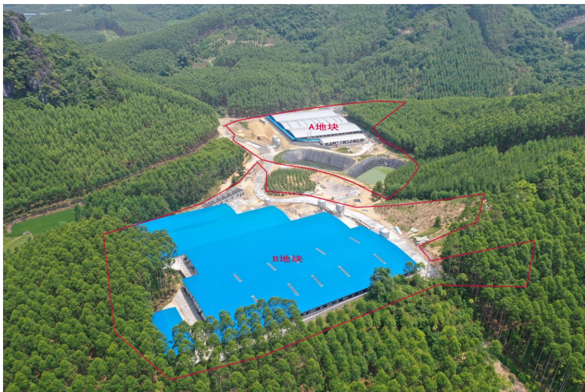
项目建成后全貌照片（2023.07）
