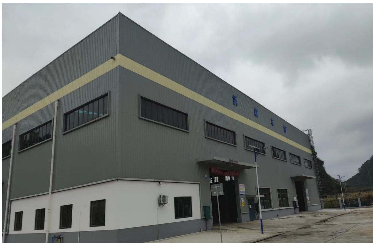
项目完工后车间现状（2024年1月）
