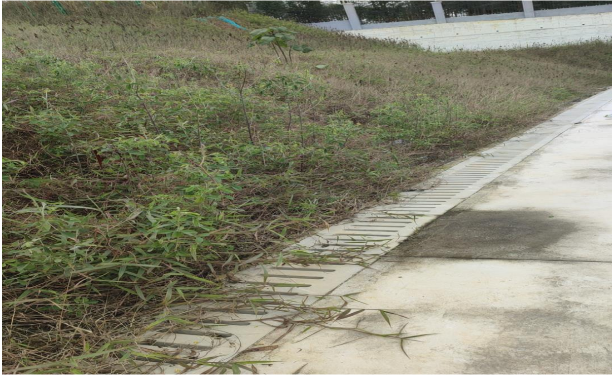
项目完工后盖板排水沟现状（2024年1月）
