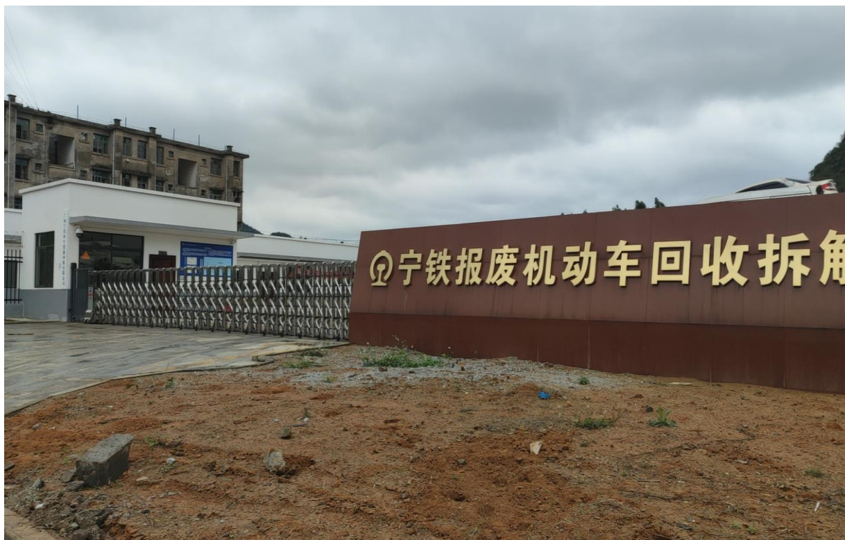
项目完工后大门现状（2024年1月）
