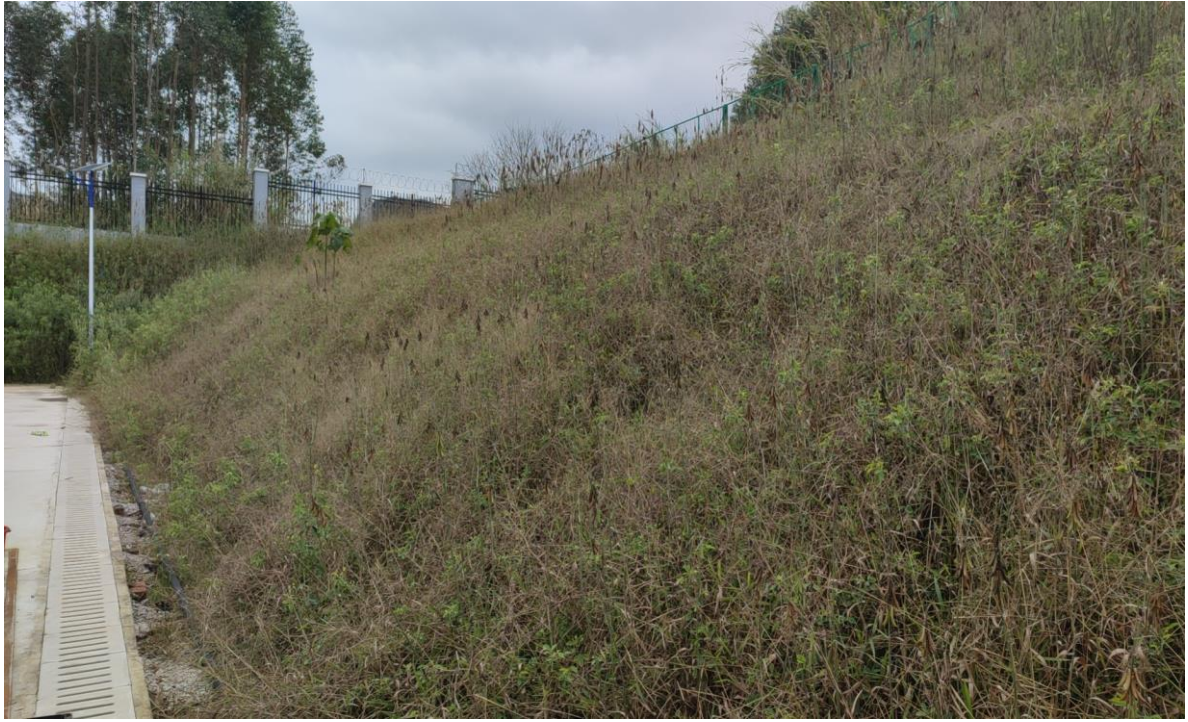
项目完工后边坡绿化现状（2024年1月）
