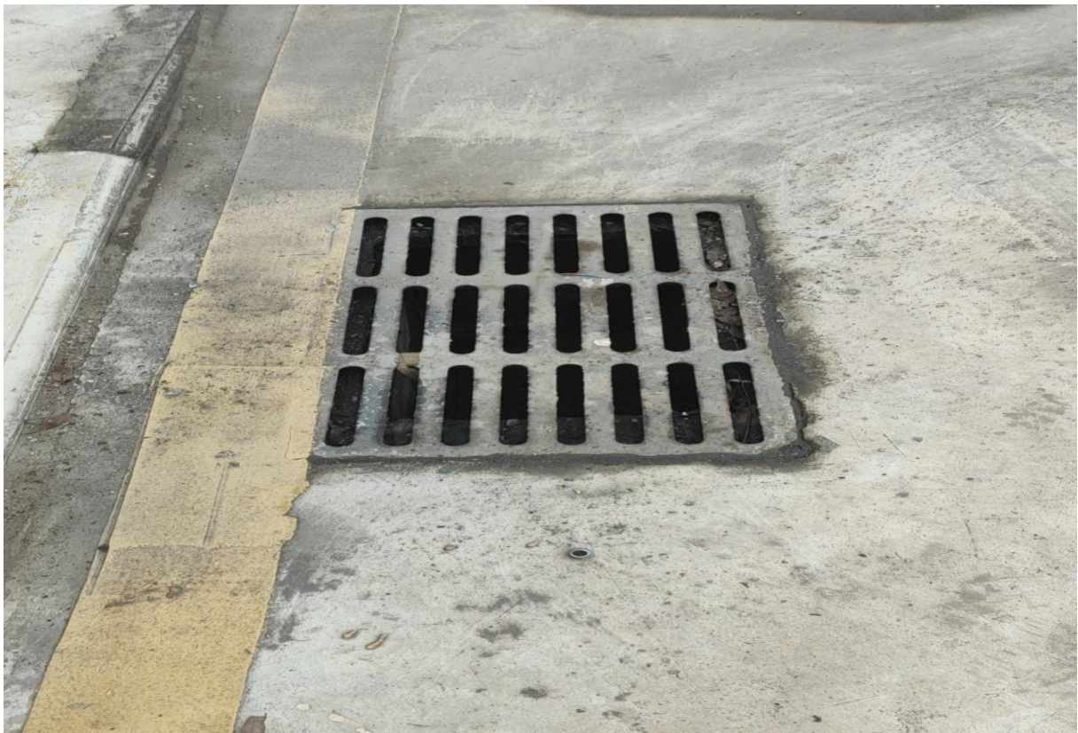
项目完工后沉砂池现状（2024年1月）
