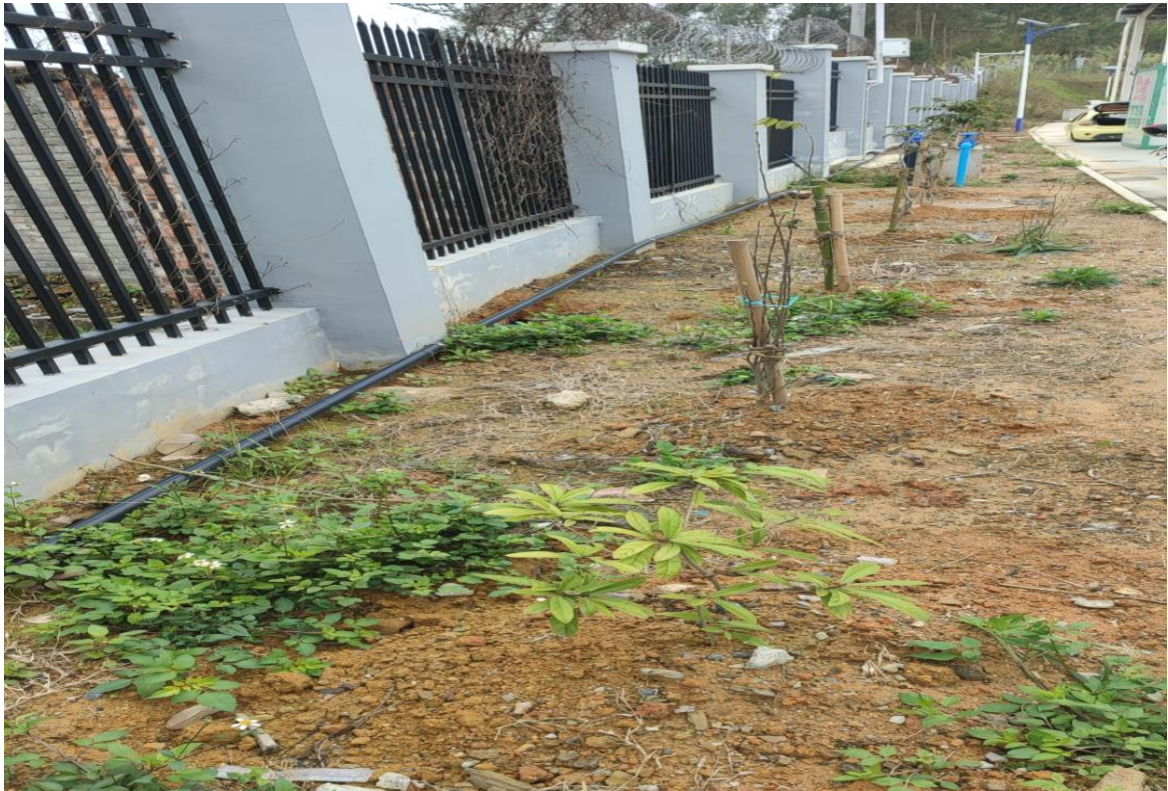
项目完工后乔木种植现状（2024年1月）
