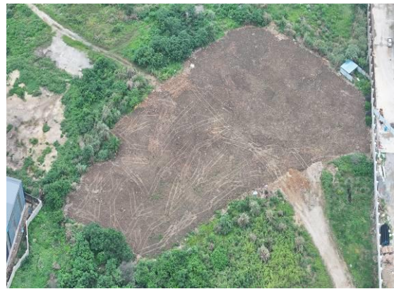
施工生产生活区绿化覆土
