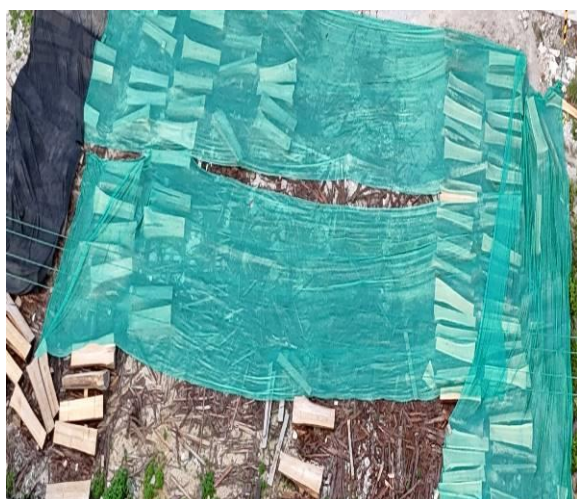
密目网临时覆盖
