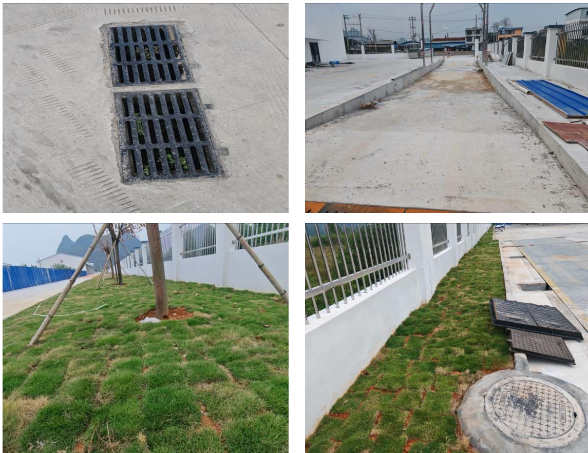
图 2.3-1 项目水土保持措施监测
