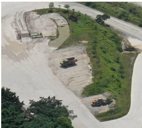
工业场地区边坡绿化
