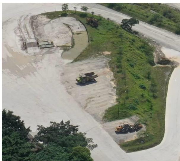
工业场地区边坡绿化
