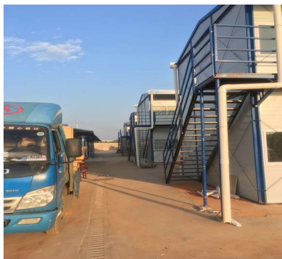
临时盖板排水沟
