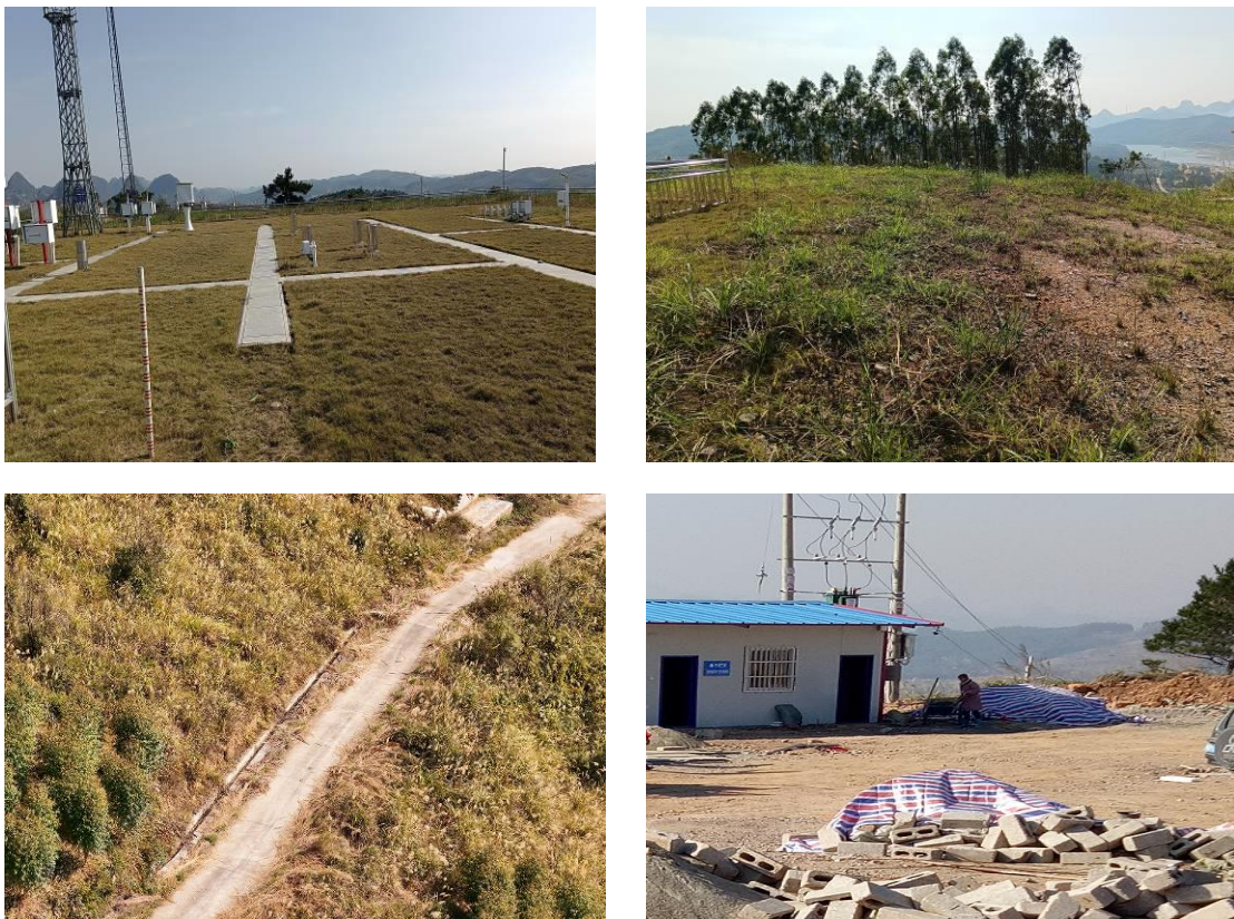
图 2.3-1 项目水土保持措施监测
