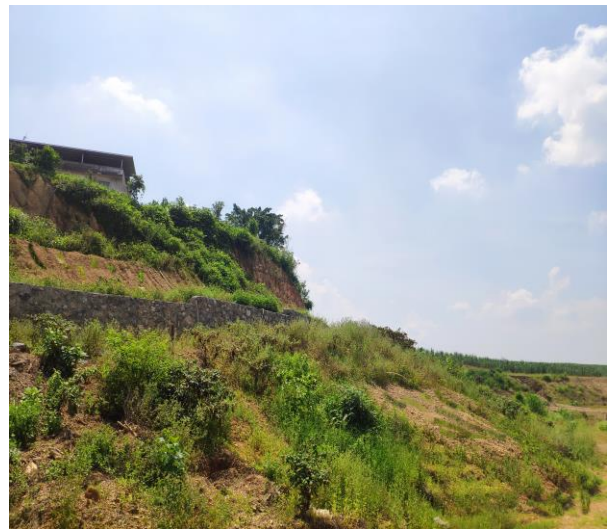
B 地块边坡绿化情况
