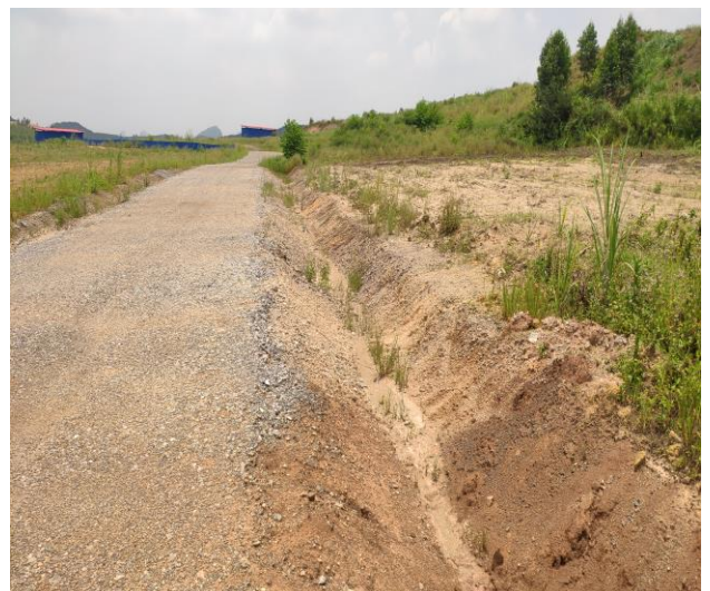
C 地块土质排水沟
