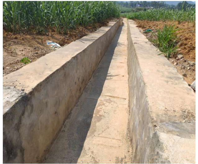
B 地块浆砌石排水沟
