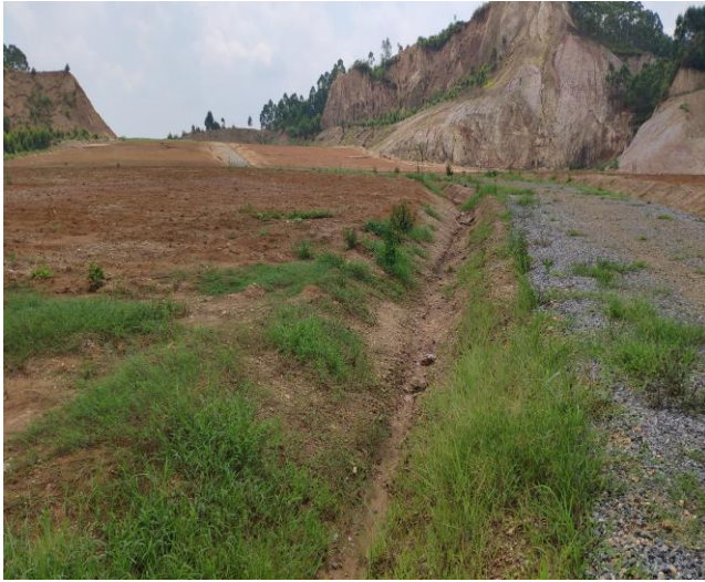
A 地块土质排水沟
