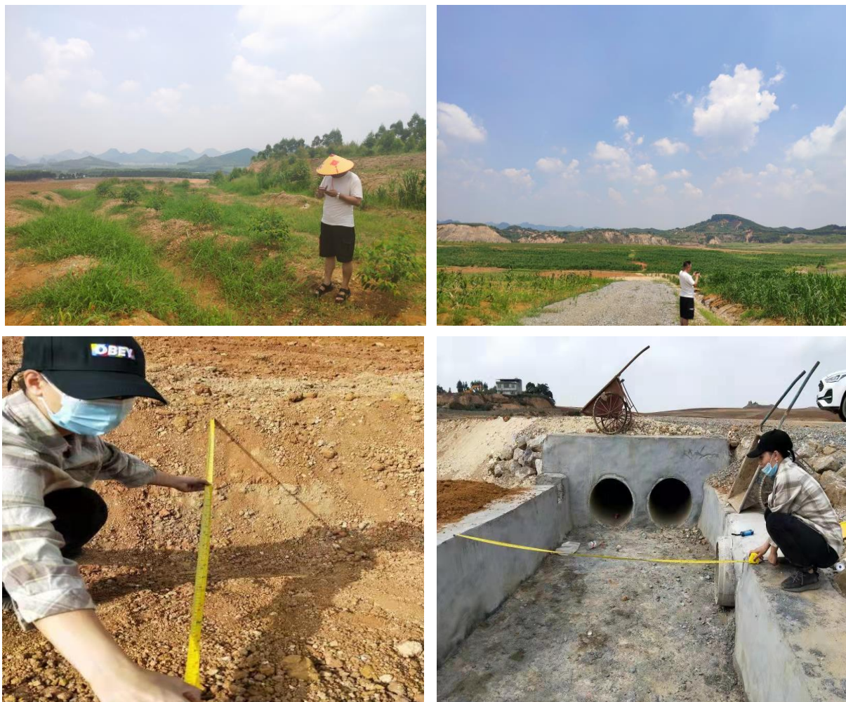
图 2.3-1 项目水土保持措施监测
