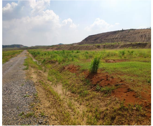
B 地块土质排水沟
